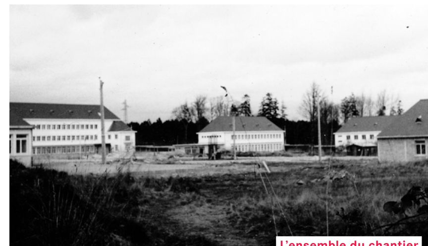
L'ensemble du chantier
