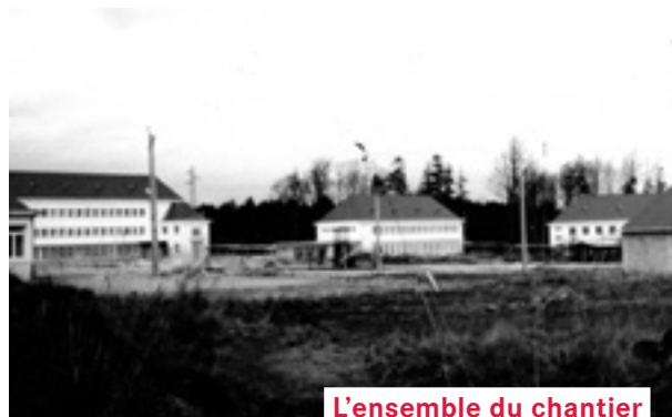
L'ensemble du chantier
